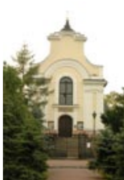
Kościół p.w. Opatrzności Bożej tzw. Wierzchowice. Fot. KOBIDZ.
