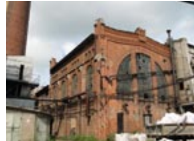
Budynek turbinowni na terenie „Nowej Papierni” – ul. Mirkowska 45. Fot. KOBIDZ.
