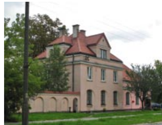
Klarysew, dworzec kolejki wąskotorowej – ul. Warszawska 64. Fot. KOBiDZ.
