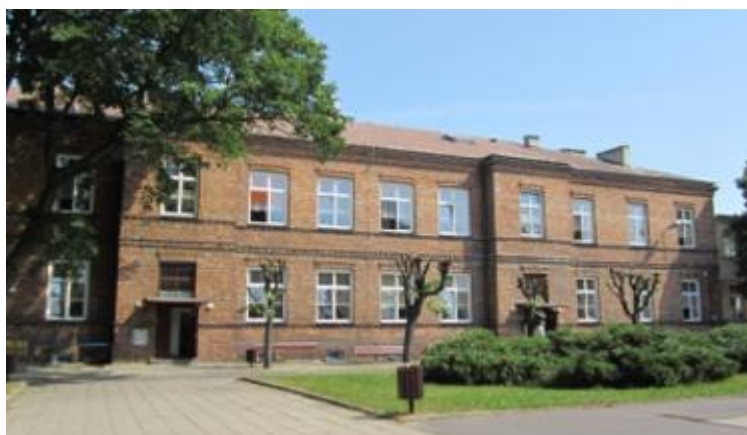
ł) Powiat Piaseczyński Góra Kalwaria Góra Kalwaria Szpitalna 1 - Pawilon nr 4 (d. koszary) z zespołu d. Konwentu Pijarów (wraz z zielenią parkową w granicach murowanego ogrodzenia) 1910
